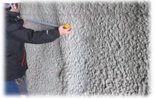
터널 공사중점검 현황 (제원조사)
