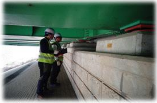
교량 정밀점검 현황 (외관조사)
