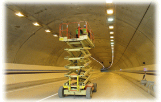
터널 초기점검 (고소차 점검)
