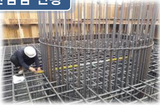
교량 공사중점검 현황 (제원조사)
