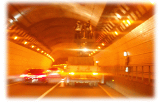
터널 정밀점검 현황 (외관조사)
